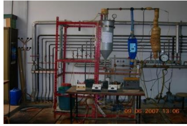
Figure 1: Photographie de l'installation semi-pilote
